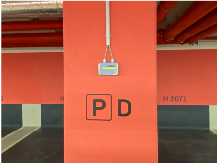
Abbildung 3: Sensoren erfassen kontinuierlich die Schadstoffkonzentration in den unterirdischen Parkzonen
