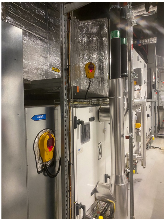
Abbildung 2: 176 Kanalrauchmelder vom Typ KRM-X überwachen die Lüftungssysteme in verschiedenen Nutzungseinheiten
